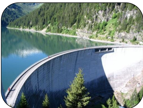
Barrage à haute chute
