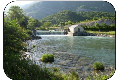
Barrage au fil de l'eau
