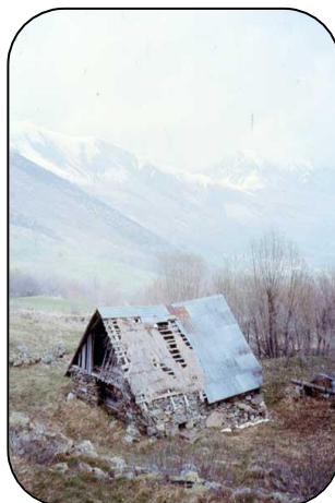
Toitures couvertes de toles
