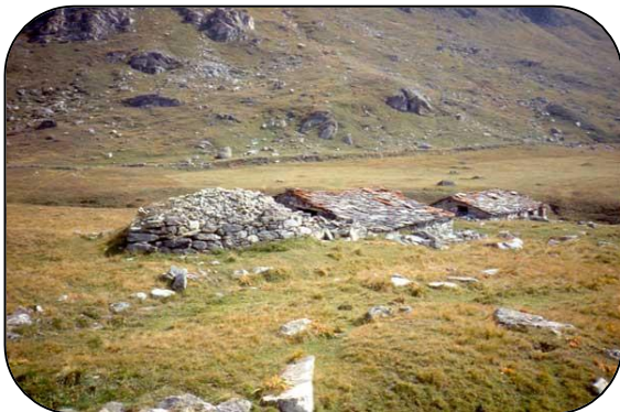
Chalet d'alpage en site avalancheux
