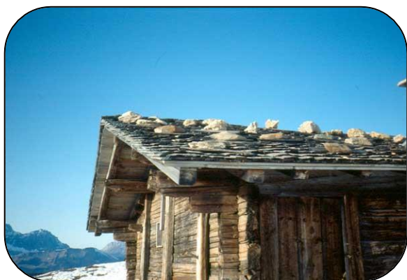
Toiture couverte en bois (grenier aux Saisies)
