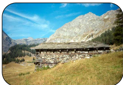
Chalet d'alpage en Vanoise où les murs en pierre sont renforcés de poutres en bois
