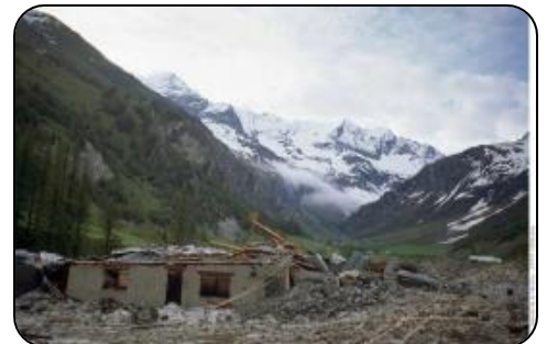
Un bâtiment détruit par une avalanche
