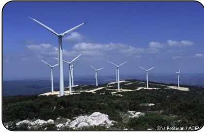
Un parc éolien
