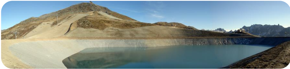
Retenue collinaire à Valloire, Savoie
