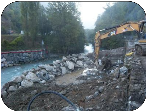
Construction d'une digue de protection à Moutier
