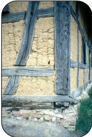
*Détail de mur composite avec pans en bois et remplissage en torchis*
