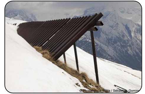
Râtelier paravalanche, combe du Replat, Isère
